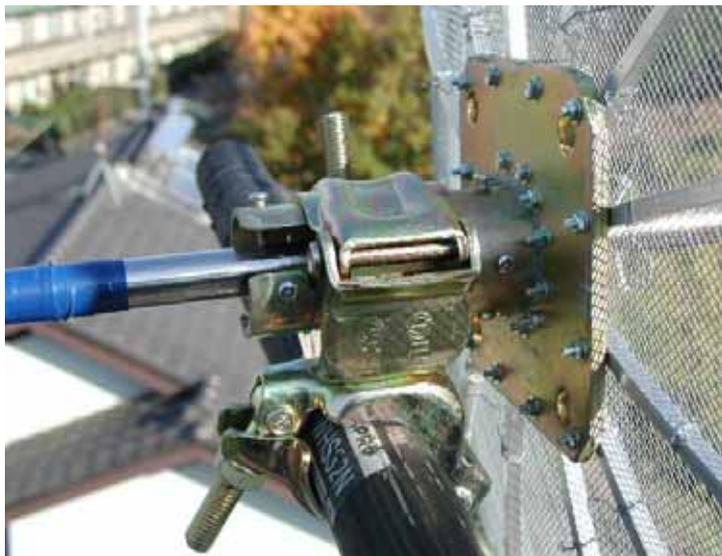
写真7.建材用クロスマウントで水平ポールに固定
